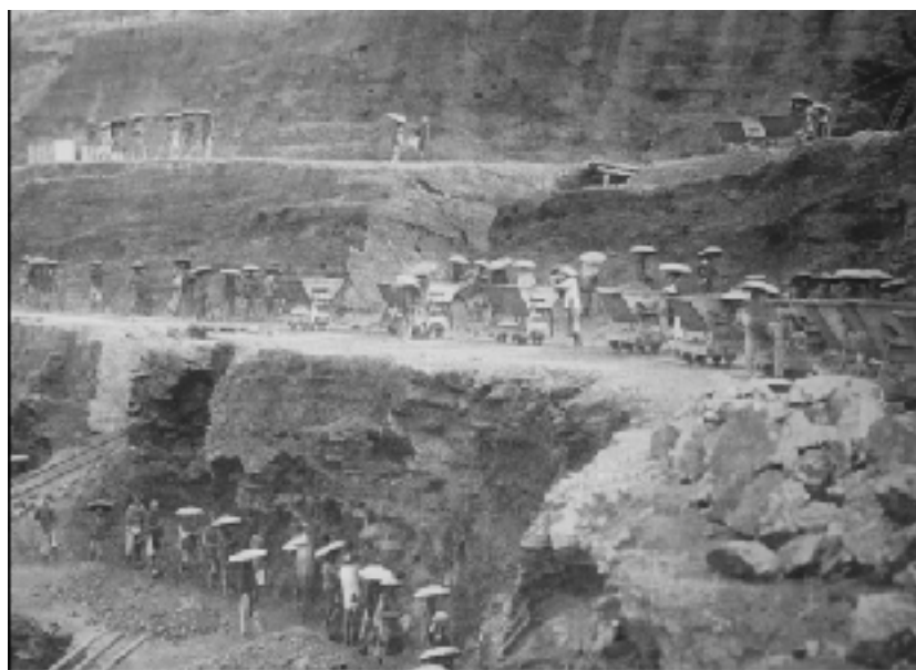
Mine à ciel ouvert de Hon Gay
